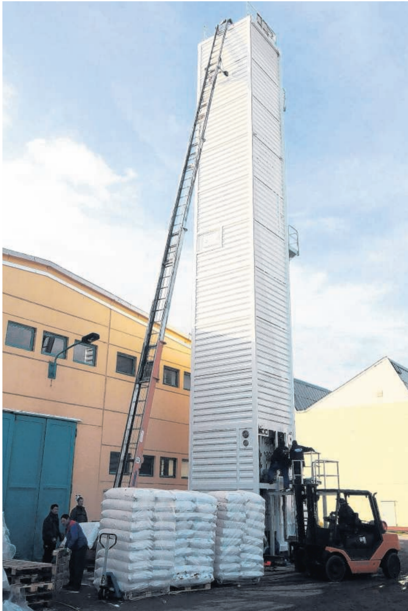
Größer als die Werkhalle: Die Cold Box misst 23 Meter. Vor ihr stapelt sich das Isoliermaterial.
