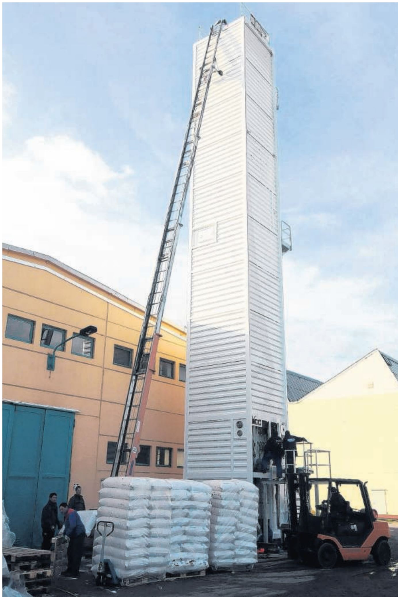
Größer als die Werkhalle: Die Cold Box misst 23 Meter. Vor ihr stapelt sich das Isoliermaterial.
